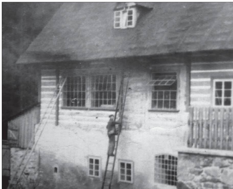
Na snímku je pohled na objekt elektrárny ze strany výtoku, vlevo se nachází objekt tzv. lednice, kde bylo umístěno vodní kolo.
