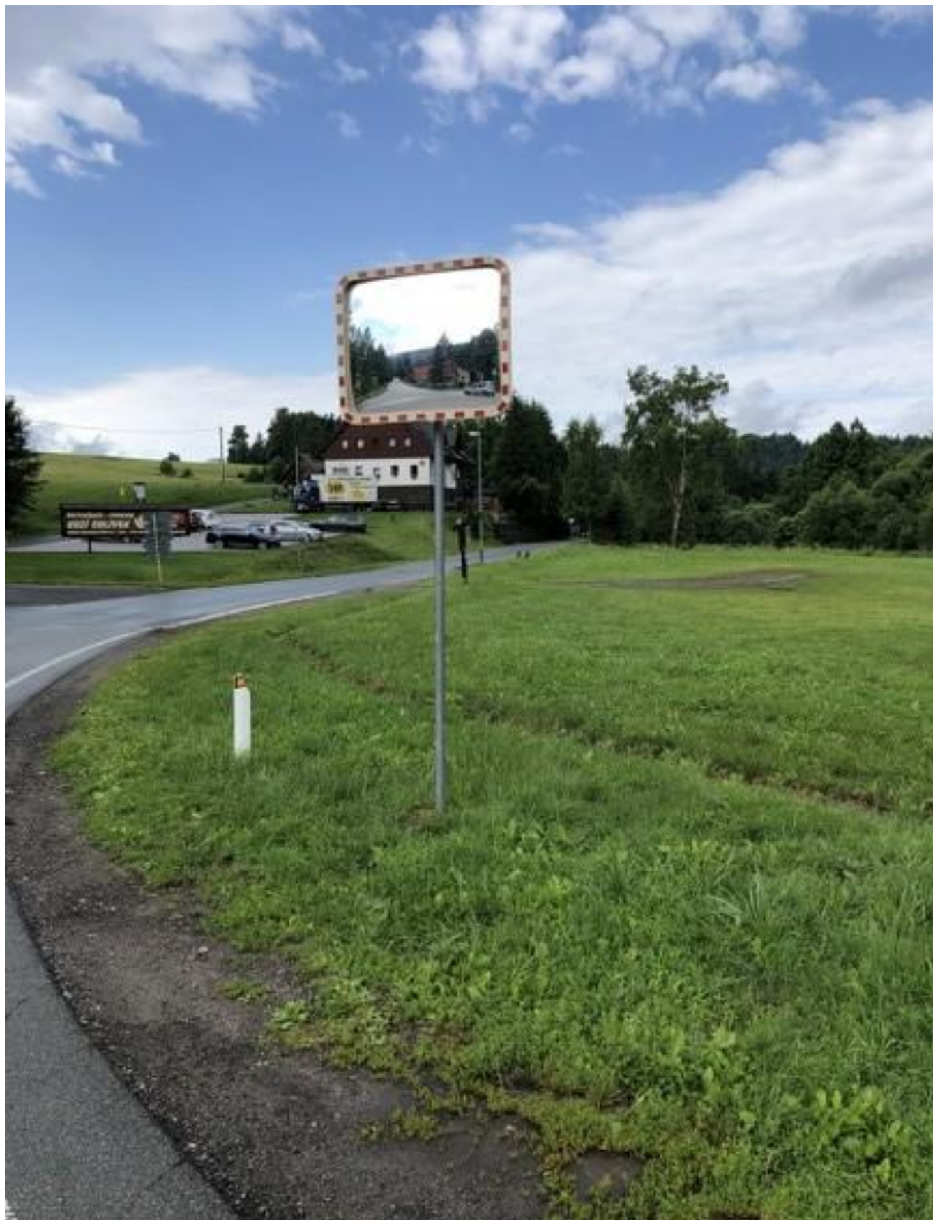
Foto 3: Stávající zařízení dopravního příslušenství, ukazatel: Dopravní zrcadlo
